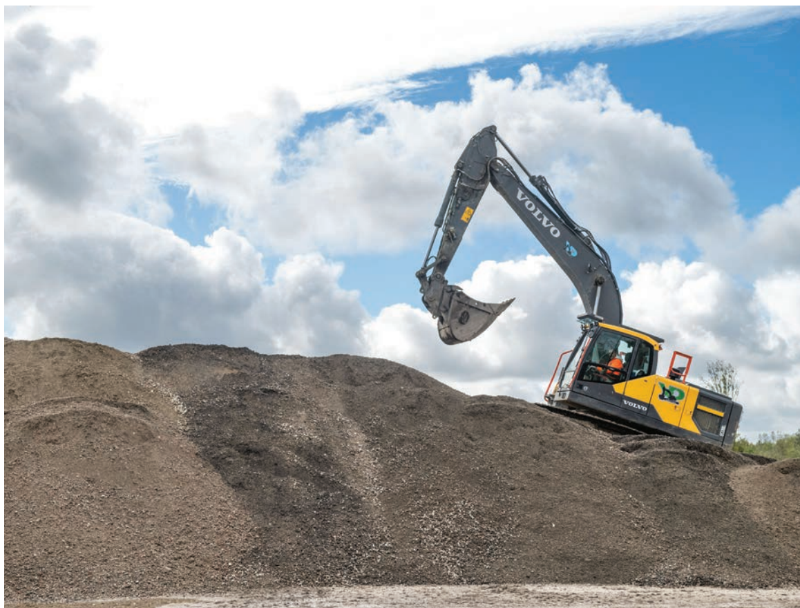
↑ Sur la plateforme d'EDYCEM à Mérignac, les déchets issus des chantiers sont triés puis transformés en granulats recyclés ou réintégrés dans la fabrication de nouveaux bétons.
